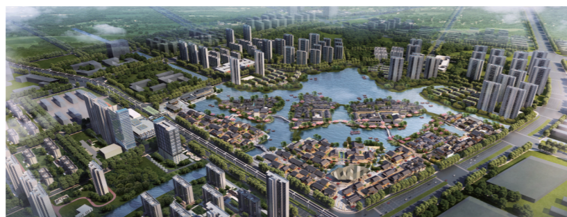
杭州湾滨海新城“锦绣东方·国风小镇”
